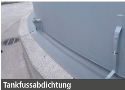
Tankfundamentabdichtung
