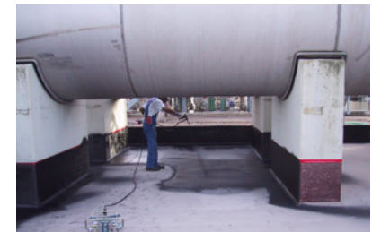
Auffangwannensanierung
