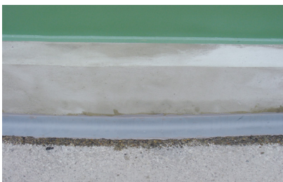
Tankfundamentabdichtung
