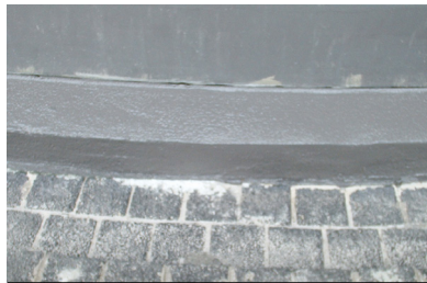
Tankfundamentsanierung
