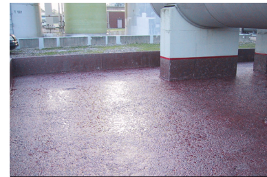
Auffangwannensanierung
