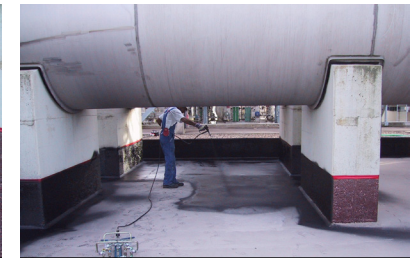
Auffangwannensanierung
